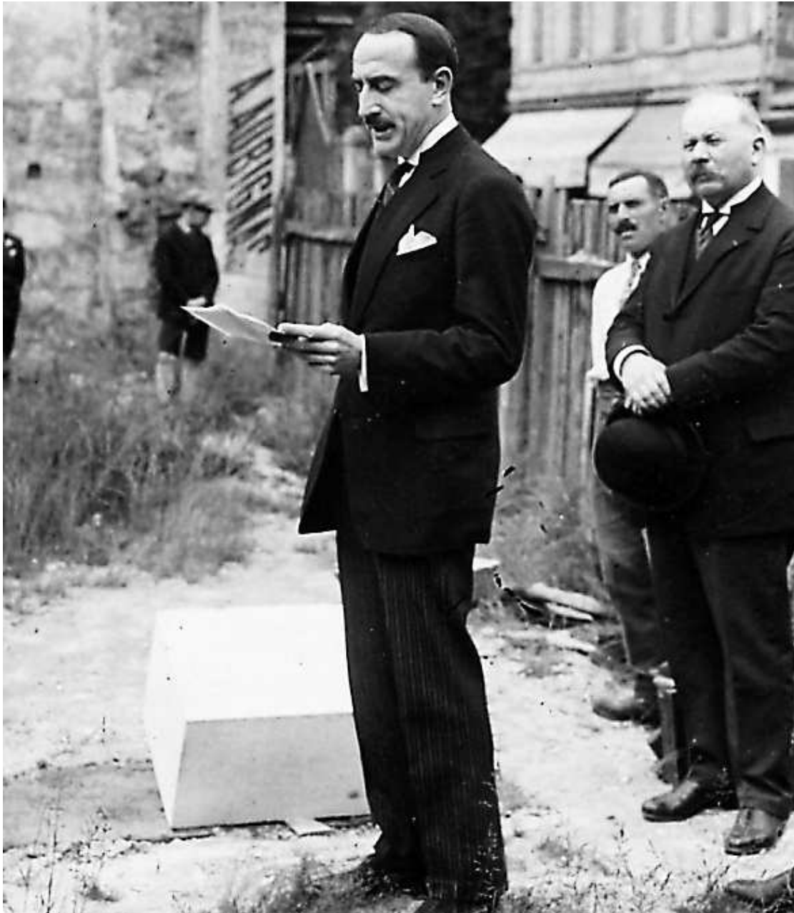
Adrien Marquet lors de la pose de la première pierre de la place Charles-Gruet, dans le quartier Fondaudège
